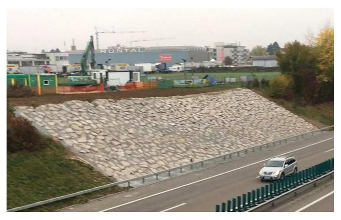
Pflastersteine sollen verhindern, dass der Hang im Falle eines nächsten Hochwassers unterspült wird.
